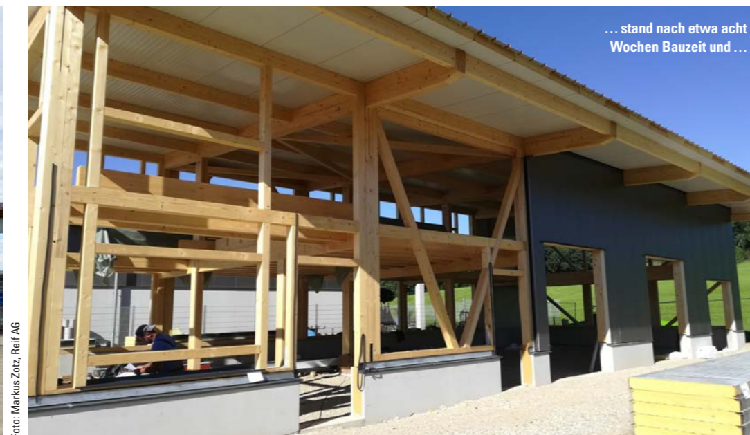
Der Holzbau der Reif AG inklusive Fundament ...
