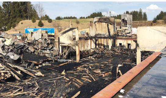
Deprimierender Anblick: das Betriebsgebäude nach dem Brand
